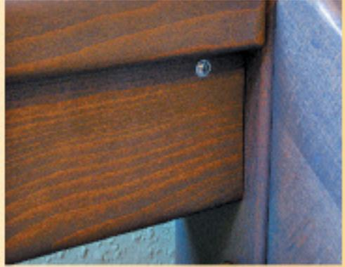
Der Beschlag ist bei fertig montierter Treppe hinter dem vorgeschraubten Stellbrett nicht mehr zu sehen.
