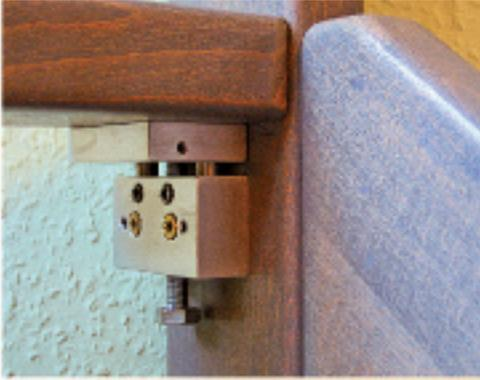
Der KSV 1 im montierten Zustand am Treppenaustritt.
